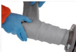
Figura 28: Envolver tiras com 50 ou 100 mm de largura de ArmaGel HT em volta do tubo. O material pode ser unido ou sobreposto em 50%.
