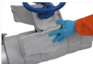
Figura 58: Envolver a haste da válvula.
