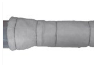
Figura 45: Aperte bem o isolamento do tubo no redutor.
