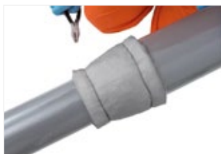
Figura 44: Encaixe à volta do redutor e prenda no lugar com fio.
