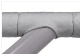
Figura 51: Envolva à volta do tubo e prenda no lugar com fio.
