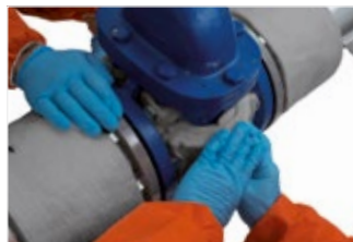
Figura 55: Embale o ArmaGel HT à volta do corpo da válvula para evitar vâcuos.
