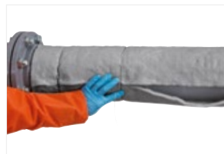
Figura 14: Continue a fazer a junta, fechando os espaços.
