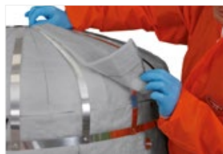
Figura 62: As juntas em camadas subsequentes devem ser sobrepostas.
