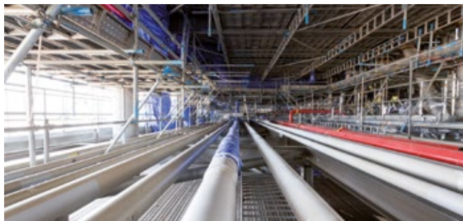
Figura 9: Se for provável condições climáticas adversas, disponibilize cobertura para as áreas de trabalho. Evite que o isolamento fique molhado.
