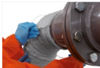
Figura 35: Certifique-se de que as juntas estão todas bem unidas sem folgas e que se encaixam no tubo sem vácuos.
