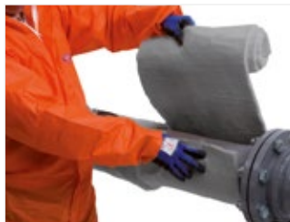
Figura 24: Garantir que o ponto inicial está alinhado com o eixo do tubo. Pode ser necessária fita ou adesivo para ajudar a fixar a posição do eixo.
