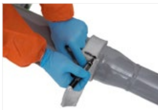
Figura 42: Meça ambas as circunferências na solda.
