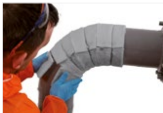
Figura 36: Prenda cada segmento no lugar com fio, permitindo movimento para um ajuste final.
