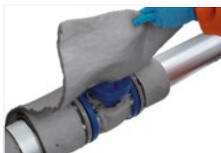
Figura 56: Envolver o ArmaGel HT à volta das flanges.
