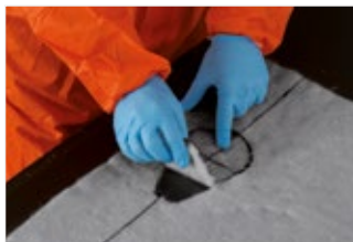
Figura 50: Crie um corte para a secção em ângulo oblíquo.
