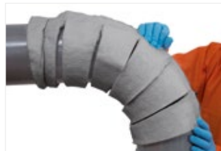
Figura 39: Posicione os cortes no interior da curva com a junta longitudinal na parte exterior da curva.
