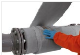
Figura 32: Envolver até à mesma espessura que o ArmaGel HT no tubo.
