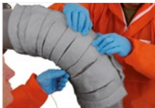
Figura 40: Empurre todos os cutelos uns contra os outros para garantir que não existem folgas nas juntas ou vácuos.
