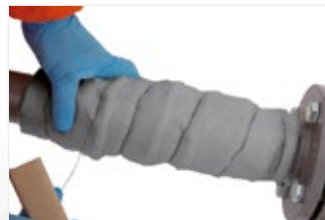
Figura 29: Envolver em espiral com arame para manter o ArmaGel HT no lugar.
