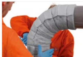
Figura 37: Empurre todos os segmentos uns contra os outros para garantir que não existem folgas nas juntas e aperte os fios.
