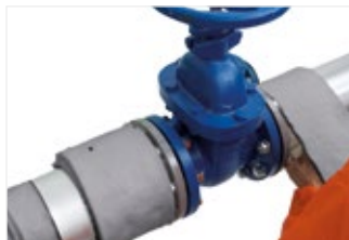
Figura 54: Envolver tiras de ArmaGel HT à volta do tubo até que o revestimento ultrapasse o diâmetro exterior da flange.
