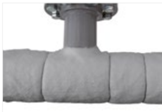
Figura 46: Revista o tubo principal à volta da secção.
