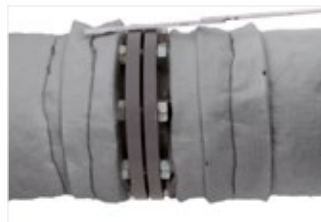
Figura 31: Envolver tiras com 50 mm (2 pol.) de largura de ArmaGel HT para criar o isolamento para libertar a flange ou ajuste a largura para ser igual à espessura total de isolamento, se for superior a 50 mm).
