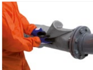
Figura 25: Continue a envolver o tubo para conseguir a quantidade necessária de camadas. Termine o envolvimento com a extremidade longitudinal alinhada com, ou sobreposta com, o ponto inicial da camada interna.
