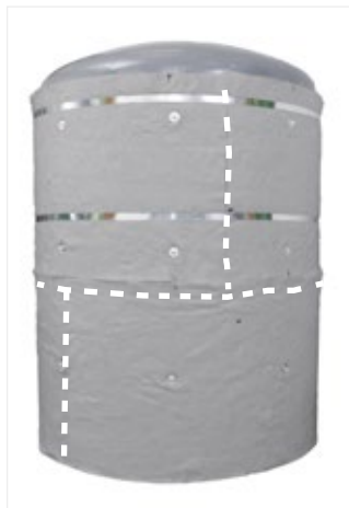
Figura 60: Revestir a partir da linha de solda da cabeça do recipiente. Segure a folha de ArmaGel HT com pinos ou clavos de isolamento, sobrepondo todas as juntas, depois uma cada camada ao recipiente.
