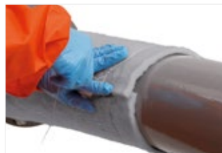
Figura 12: Junta longitudinal sobreposta.
