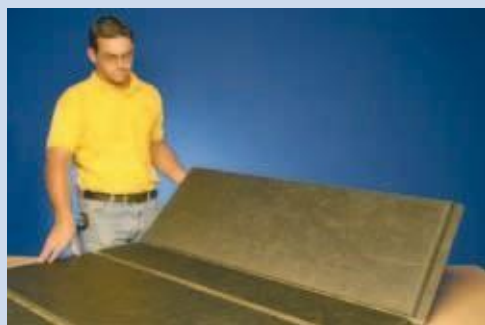
1. Traçar e cortar os painéis.
